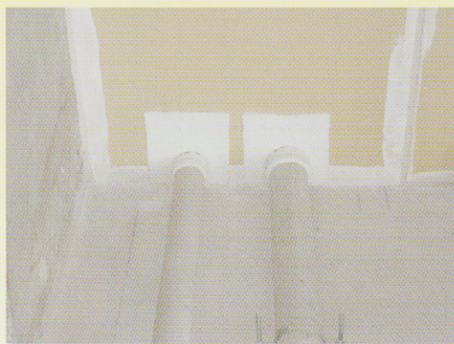
石膏ボード貫通口
