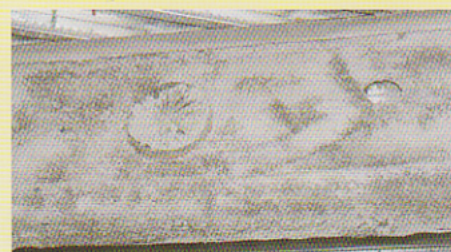
No.3 耐火被覆材吹き付け後
